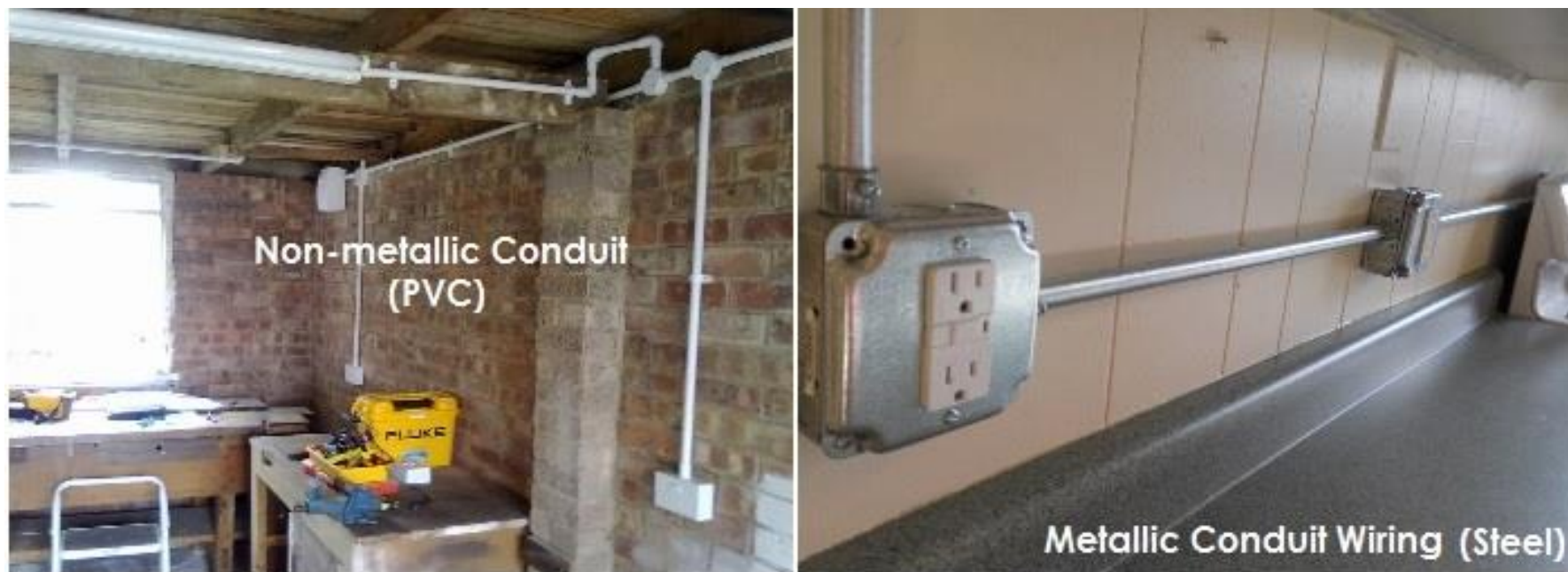
Surface Conduit Wiring
