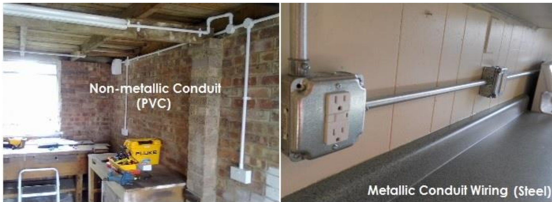
Surface Conduit Wiring
