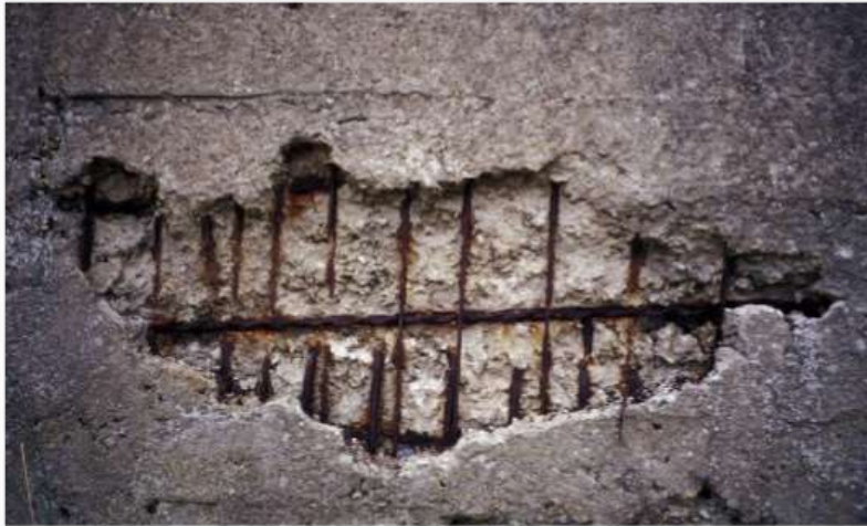
Spalling
