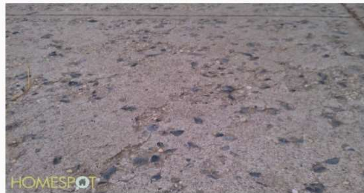
Spalling
